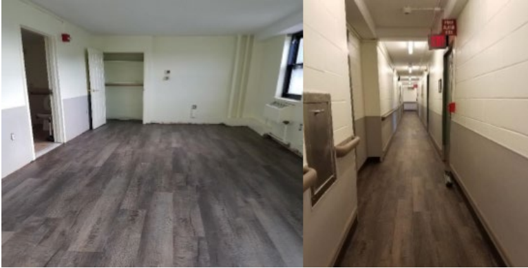
Reducción del corredor y mejoras en las unidades residentes en Kennedy Tower
