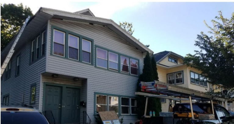
Reemplazo del techo en Scattered Sites
